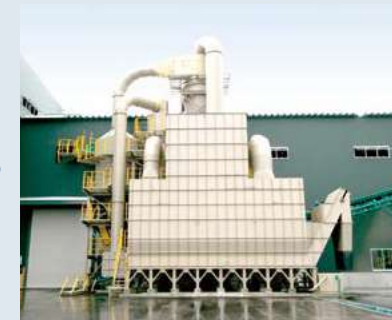
集塵装置 対象物を破碎した際に発生した粉塵を回収します。
