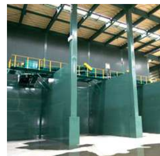
ダスト保管ヤード
