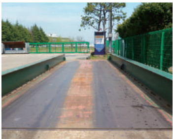
本社 80tトラックスケール
