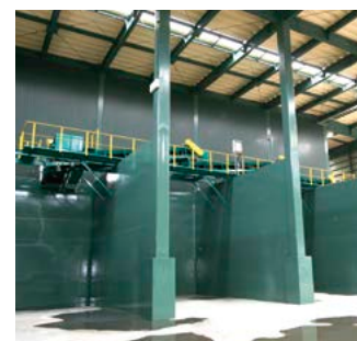
ダスト保管ヤード
